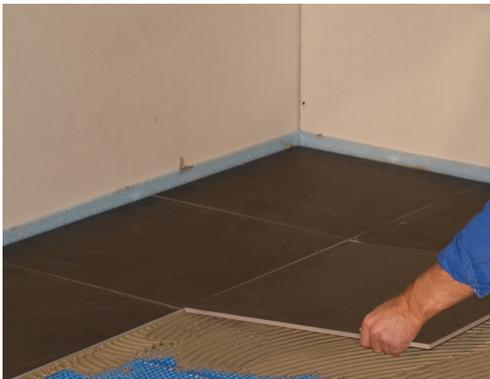
**9** Verlegen der Fliesen auf dem Belagsträger. Zur Verlegung der BLANKE PERMAT und der Fliesen ist ein Dünnbettmörtel C2 S1 nach DIN 12004 bzw. 12002 zu verwenden. Bei Natursteinen ist ein darauf abgestimmter und geeigneter Dünnbettmörtel zu verwenden.
