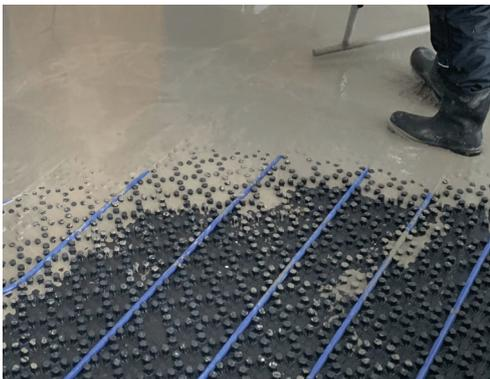
**6** Nachdem alle Heizkreise verlegt sind, erfolgt das Vergießen der Heizleiter und der Systemnoppenplatte. Hierzu wird BLANKE FILLTHERM mit einer Noppenüberdeckung von mindestens 8 mm eingebracht. Eine maximale Überdeckung der Noppenstruktur von 25 mm darf nicht überschritten werden. BLANKE FILLTHERM ist auch pumpfähig. Anmachwassermenge von 3,5 l Wasser auf 25,0 kg Pulver einhalten.
