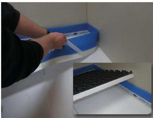
**2** BLANKE RANDDÄMMSTREIFEN (RDS) an allen aufsteigenden Bauteilen anbringen. Den an dem Randdämmstreifen befindlichen doppelseitig, selbstklebenden Folienfuß auf der oberen Dämmlage bzw. dem vorhandenem Untergrund aufkleben. BLANKE BF+/BFC Noppenplatte im Anschluss verlegen und die Systemnoppenplatte von oben auf den Randdämmstreifen aufbringen und mit dem Randdämmstreifen verkleben. Eine Hinterläufigkeit muss ausgeschlossen sein.
