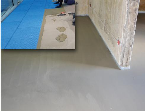
**8** Nachdem BLANKE FILLOTHERM die Verlegereife erreicht hat, wird nach Grundieren mit Blanke GROUND die Belagträger- und Entkopplungsmatte BLANKE PERMAT für nachfolgende keramische Beläge und Natursteine verklebt.
