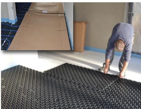
**3** Die Systemnoppenplatten sind 50 mm überlappend zu verlegen und werden im Bereich der zweiseitigen Überlappung ineinander geklickt (Druckknopftechnik). Die fertig verlegten Systemnoppenplatten sind generell direkt nach dem Auslegen zu schützen!
