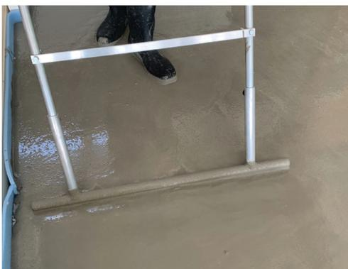
**7** Den frisch eingebrachten BLANKE FILLTHERM mittels Schwabbelstange im Kreuzgang bearbeiten. Dabei sind die Höhen zu kontrollieren. Achtung: Fläche nicht mit Nagelschuhen begehen. Während der Aushärtung ist die Fläche vor Zugluft zu schützen. Die fertige, dünnschichtige BLANKE Filllotherm-Fläche (8 - 25 mm) ist direkt nach Begehbarkeit zu schützen und abzudecken bis der endgültige Bodenbelag eingebracht wird.
