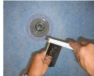
2. Die Anker von Blanke•RENOROST auf die gewünschte Fliesenstärke mit einer Spitzzange umknicken (Einrastungen für 4 mm/8 mm/10 mm und höher).
