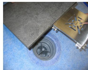
3. Fliesenkleber auf die Auflagestellen mit einer Zahnkelle auftragen. Den Rahmen fest in das Kleberbett eindrücken und ausrichten.
