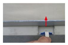
Enfiler l'accessoire de levage de grille par le dessus dans la rainure du bouchon de vidange et retirer celui-ci en direction du mur ou dans le sens inverse, selon l'installation.
