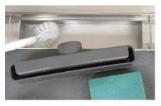
Éliminer les saletés importantes se trouvant dans le corps du caniveau à l'eau chaude courante et avec des produits de nettoyage usuels. S'aider pour cela d'une éponge ou d'une brosse. Procéder de la même façon pour le nettoyage du siphon. Graisser le manchon d'emboîtement du siphon avant de remettre ce dernier en place, par ex. à l'aide de graisse pour robinets ou de vaseline
