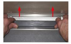
Saisir le siphon des deux côtés et le sortir du raccord d'écoulement en direction du mur ou dans le sens inverse, selon l'installation.
