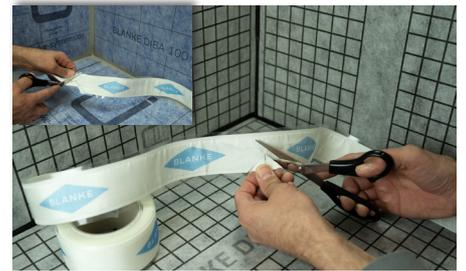
**3** Der Zuschnitt des Schnittschutzbandes erfolgt mit einer Schere. BLANKE DI-SECURE ist so zu schneiden, dass es ohne Überlappung zu verlegen ist, um einen möglichst dünnen Auftrag zu gewährleisten. Überschüssiges Material ist mittels Schere zu entfernen.
