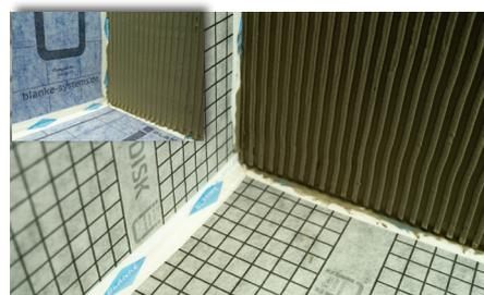
**5** Auf die ausgeführte Abdichtung im Verbund mit BLANKE DI-SECURE ist der auf den Oberbelag abgestimmte Dünnbettmörtel C2/ S1 nach DIN EN 12004 u. 12002 vollflächig aufzutragen.
