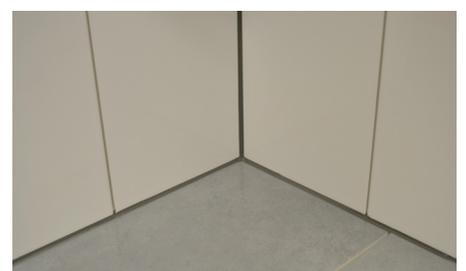
**6** Der Fliesenbelag ist nach den derzeit gültigen Normen und Regeln zu erstellen. Nach der angegebenen Trocknungszeit des Dünnbettmörtels ist der Belag auszufugen. Im Nachgang sind die Eck- und Übergangsbereiche mit neutral-vernetztem Silikon zu versiegeln.
