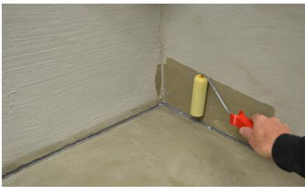
**1** Alle Untergründe müssen trocken, tragfähig und frei von haftungsmindernden Schichten sein. Die Ebenheit muss dabei der DIN 18202 entsprechen. Saugende Wand- und Bodenflächen sind zu grundieren, nicht saugende Untergründe sind bei BLANKE DISK nur grundzureinigen. Die jeweiligen Herstellerangaben für die Trocknungszeit sind zu beachten.
