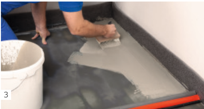
■ Auftragen der angerührten Haftbrücke
