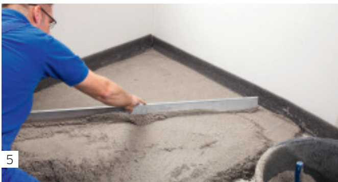
■ Verdichten und abziehen
