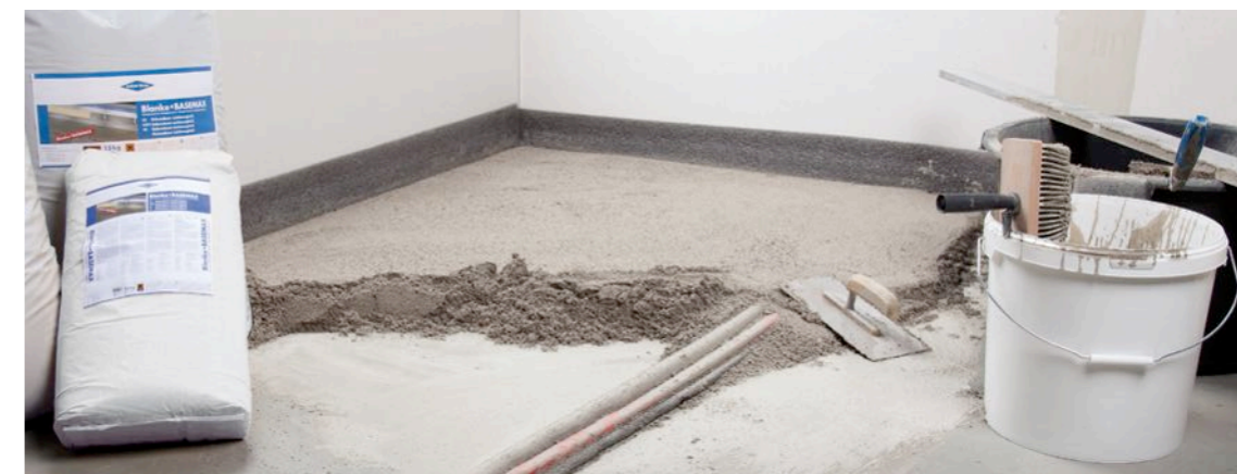
Probleemloos inwerken van buizen en snoeren
