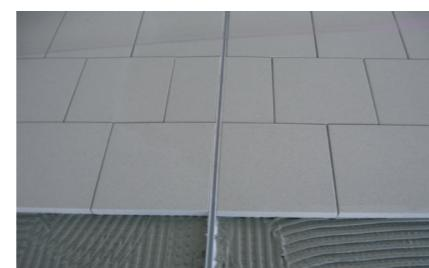
7. Die Vertiefungen der Gitterstruktur werden mit Fliesenkleber gleichmäßig abgespachtelt. Mit der auf die Fliese abgestimmten Zahntaufel wird dann der Fliesenkleber frisch aufgekämmt und die Fliesen eingelegt.
