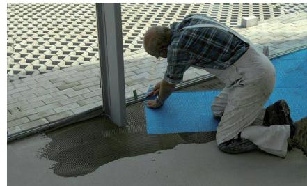
6. Coupez les nattes de désolidarisation aux dimensions souhaitées avec un couteau ou des ciseaux. Après avoir taloché BLANKE PERMAT sur la couche de colle-mortier fraîche, il faut respecter la durée de prise respective du mortier en couche mince utilisé.
