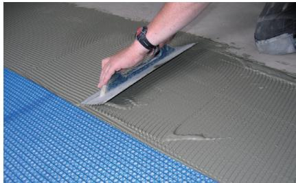
2. Appliquez une colle-mortier selon la norme DIN 12004 C2 ou 12002 4 S1 avec une spatule à 4 ou à 6 dents. Empêchez des tensions par rapport aux éléments de construction verticaux.
