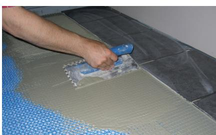
7. Les creux dans la structure du treillis sont à égaler à l'aide d'une spatule. Peignez ensuite la colle-mortier avec la truelle dentée correspondant aux carreaux utilisés et posez les carreaux immédiatement dans le lit de colle frais.
