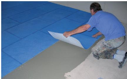
4. En tête des nattes ou sur un côté longitudinal se trouve une saillie en treillis de fibre de verre (3,0 cm). Elle sert à relier les zones de jonction. Un renforcement supplémentaire des joints n'est pas nécessaire. Poussez les nattes jusqu'à ce qu'elles se touchent complètement.
