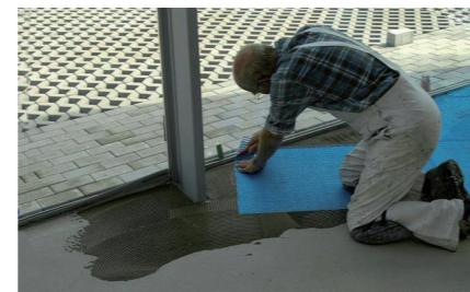
4. Die Matten sind auf einer Kopf- bzw. auf einer Längsseite mit einem überstehenden Glasgittergewebe ausgestattet (3,0 cm). Dieses ist zum Verbinden der Stoßbereiche vorgesehen. Eine weitere Armierung der Stoße ist nicht erforderlich. Die einzelnen Matten werden dicht gestoßen.
