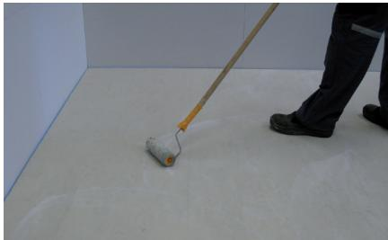
1. Les supports doivent être libre de composants empêchant l'adhérence. La planéité doit être conforme à la norme DIN 18202. Les supports doivent être porteurs et solides. Appliquez éventuellement un mastic d'apprêt approprié sur le support.
