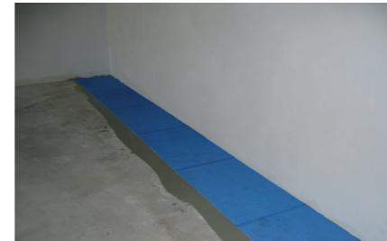
1. Untergründe müssen frei von haftungsfeindlichen Bestandteilen sein. Die Ebenheit muss der DIN 18202 entsprechen. Der Untergrund muss tragfähig und fest sein. Abgestimmt auf den Untergrund ist gegebenenfalls eine Grundierung aufzubringen.
